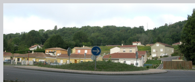
Développement de l'habitat pavillonnaire dans les pentes
