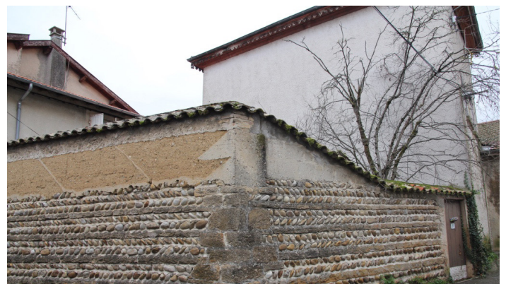
Murs de clôture en galets et pisé reliant deux constructions
