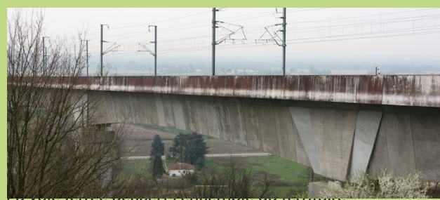
La voie ferrée découpe l'ensemble du territoire
